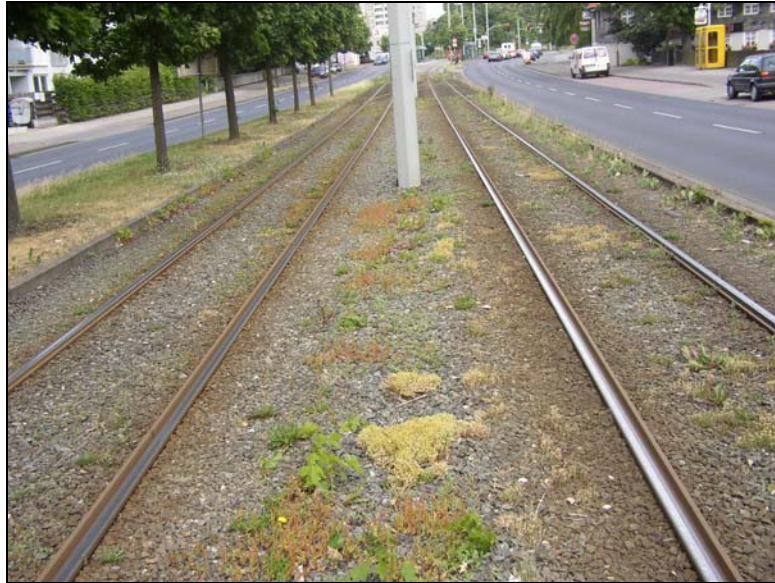
Abb. 1. Blick auf die Stadtbahntrasse in der Berliner Straße.
